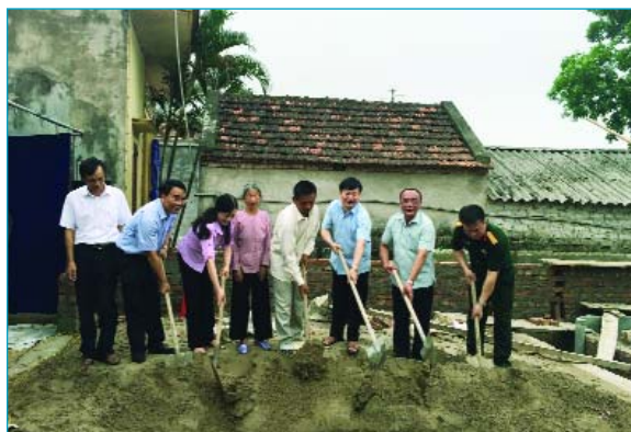
Đ/c Nguyễn Văn Phóng, Phó Bí thư Tỉnh ủy, Chủ tịch UBND tỉnh (thứ 3 từ phải sang) cùng lãnh đạo: UBMTTQ tỉnh, Viettel Hưng Yên, huyện Phù Cừ khởi công xây dựng nhà tình nghĩa cho gia đình thân nhân liệt sỹ xã Đình Cao. Ảnh: Tư liệu
